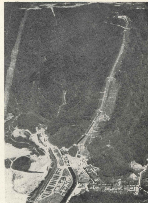
Fig. 10 - Veduta aerea dell'impianto in esercizio di Cubatão e del cantiere per la costruzione della nuova centrale sotterranea.
