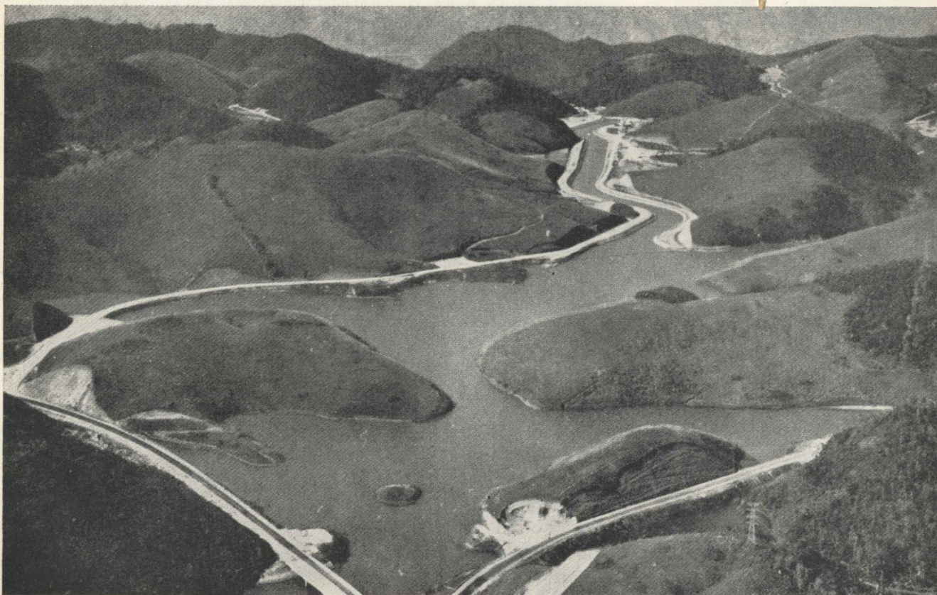
Fig. 13 - Veduta aerea del serbatoio di Vigário, con il canale adduttore.
