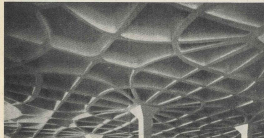
Solaio piano (1951, Nervi) con nervature ad andamento isostatico.
