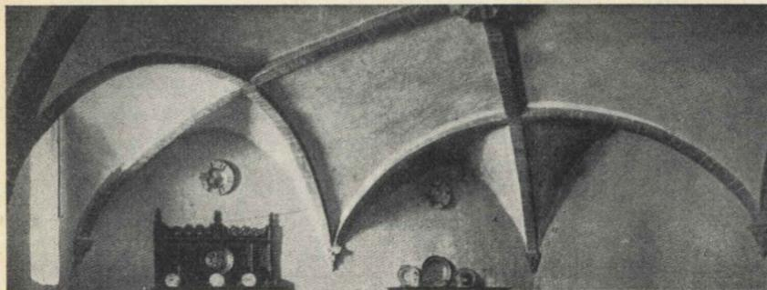
Volta ogivale nel Castello d'Issogne in Valle d'Aosta. Le diagonali sono tagliate da archi impostati sulle mezzarie delle pareti.
