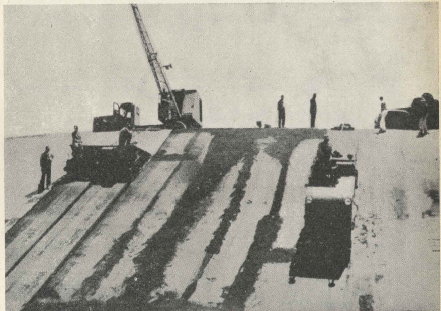
Fig. 10 - Cantiere per la posa in opera di conglomerato bituminoso sul paramento a monte di diga in terra. (Bonny Dam, Colorado - U.S.A.) [6].
