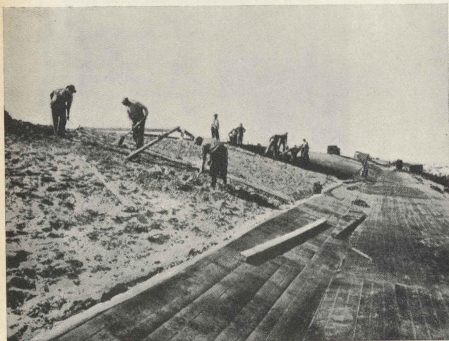
Fig. 11 - Rivestimento bituminoso di una diga marittima (Olanda) [19].
