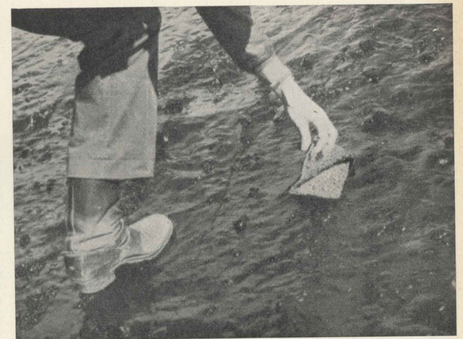
Fig. 1 - Membrana bituminosa posta in opera [26].
