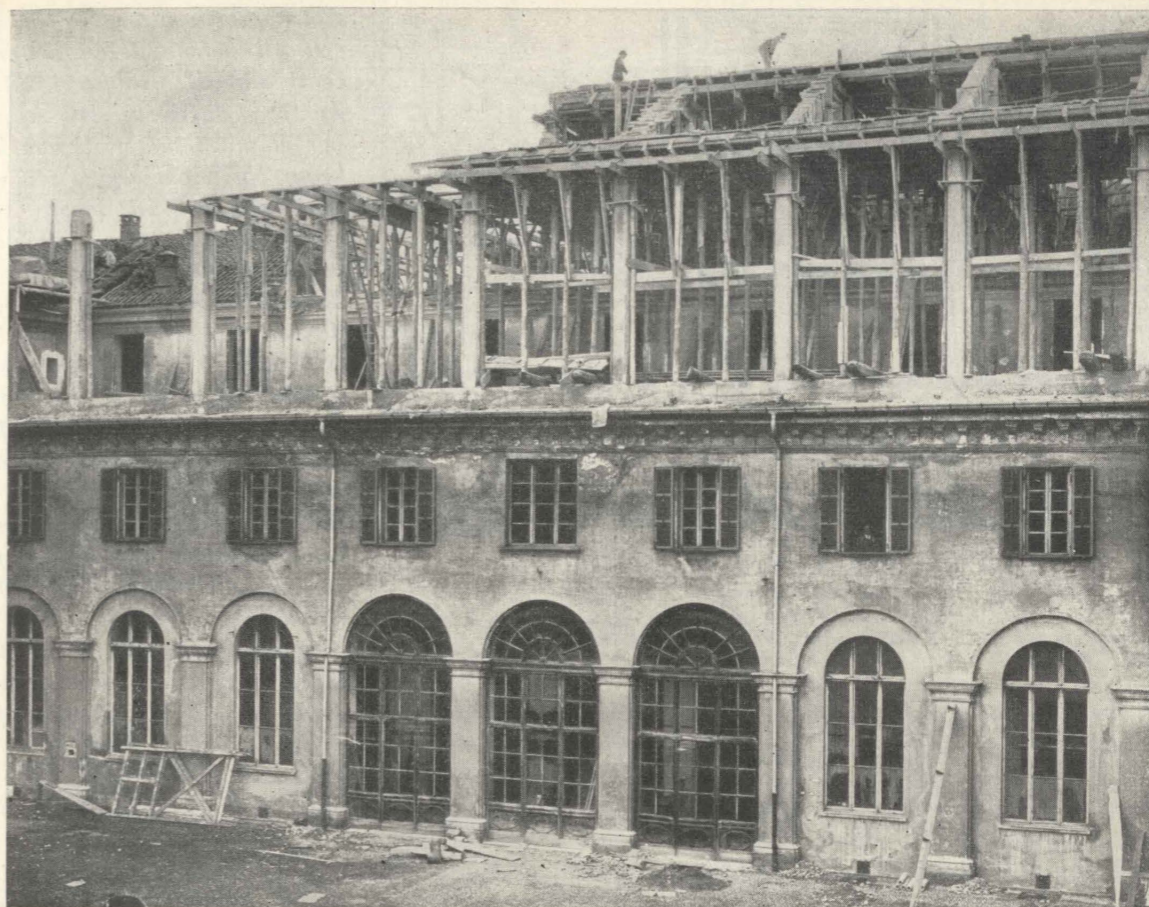
L'antica sede di via Ospedale: è in costruzione il sovralzco del corpo centrale tra i due cortili.
