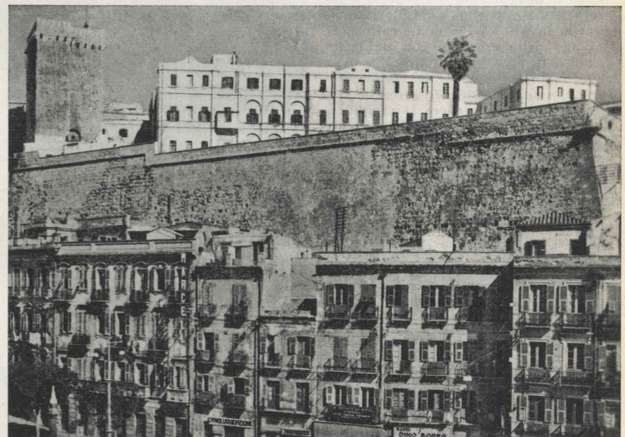
Fig. 10 - Il Bastione del Balice con la facciata verso mare degli edifici universitario e seminarile, incompleta di cornice ed accecata con muricci non congegnati all'idea architettonica di progetto.
