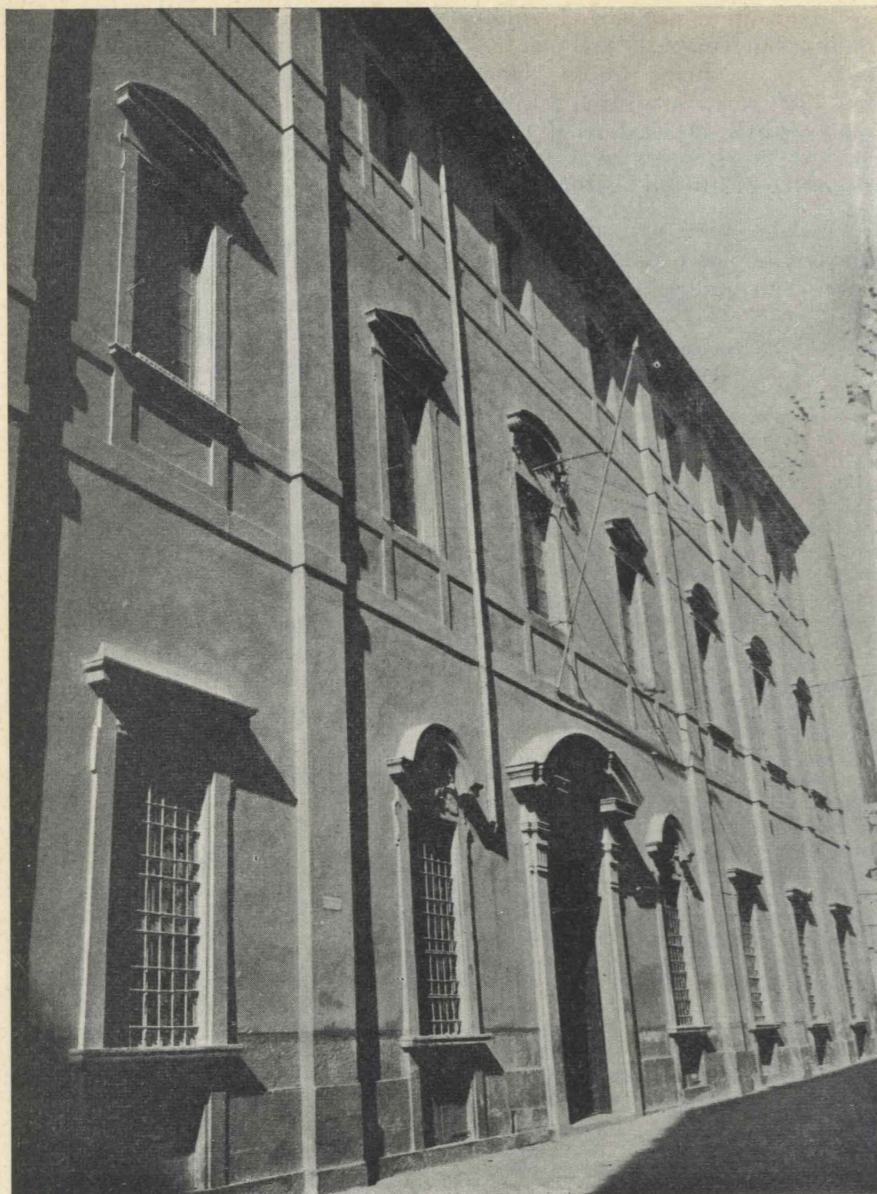
Fig. 5 - La zona della facciata dell'Università di Cagliari verso città, con la porta d'ingresso.
