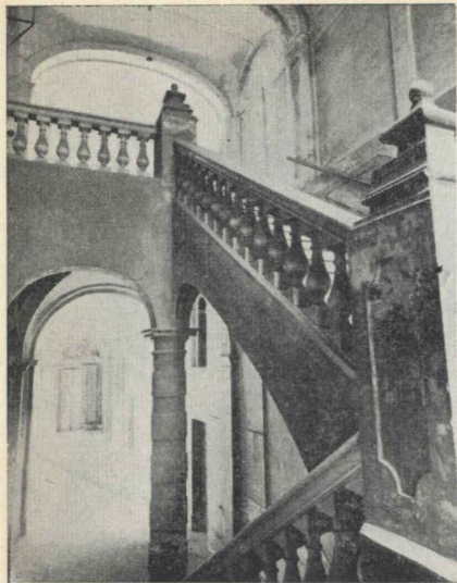
Fig. 17 - Le ultime rampe dello scalone del Seminario di Cagliari.
