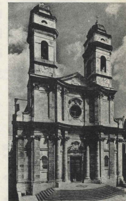
Fig. 27 - La facciata della Chiesa di Sant'Anna nel rione di Stanpace a Cagliari (anno di ultimazione 1786).
