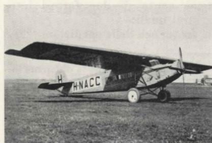
Fig. 1 - Il prototipo dello F.VII, con carrello a ruote di grande diametro, nel 1924 sulla pista di un aeroporto olandese.
