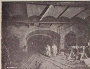
Fig. 15. - Costruzione di una stazione della Metropolitana di Parigi.
