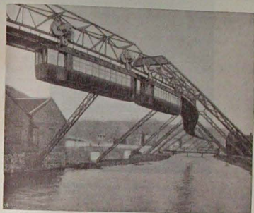
Fig. 20. — Ferrovia Barmen-Eiberfeld Linea sulla Wupper.
