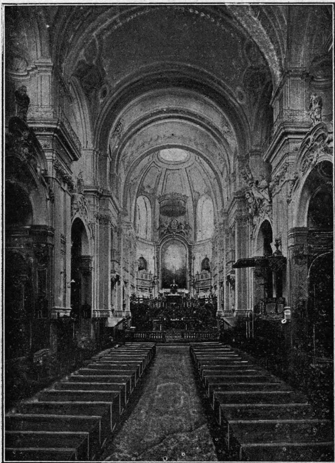
INTERNO DELLA CHIESA PARROCCHIALE DEL CARMINE.
