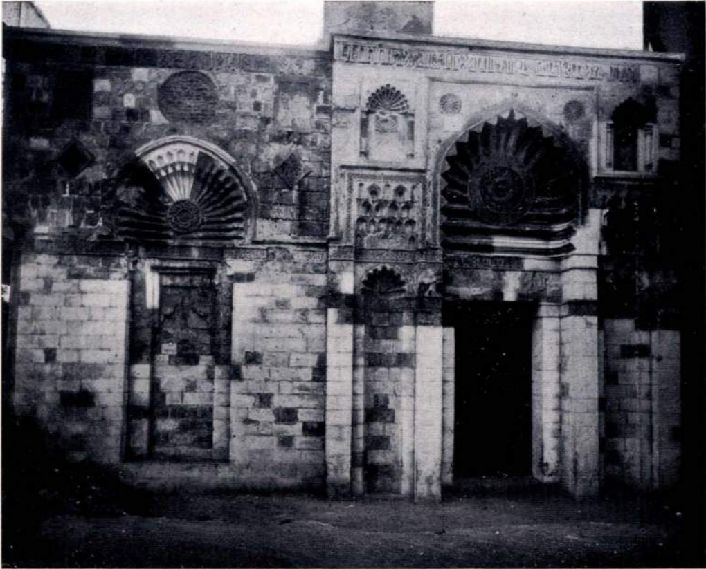
Fig. 152 — Cairo. Facciata della moschea al-Aqmar (sec. XII).
