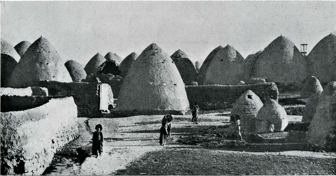
10 - Capanne di terra presso Aleppo.
