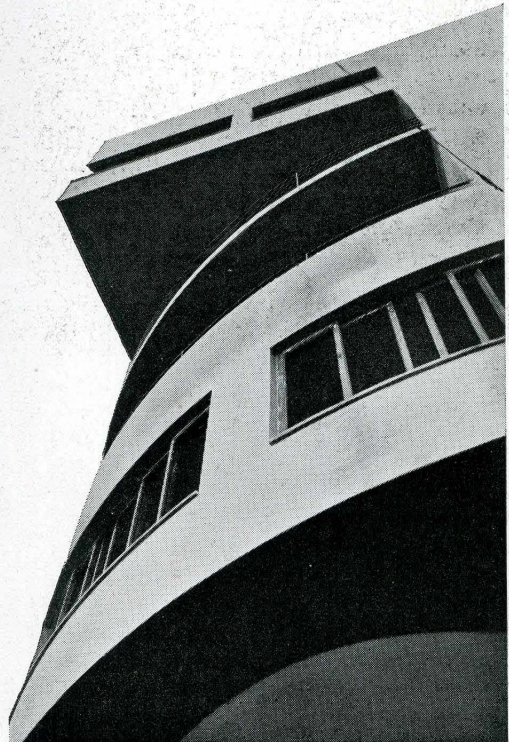
271 - Particolare del corpo angolare a sbalzo del quarto piano.
