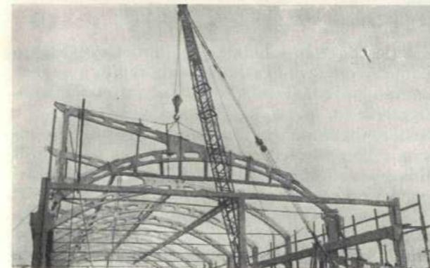
Fig. 7. - Messa in opera degli archi shed prefabbricati a copertura del capannone principale.
