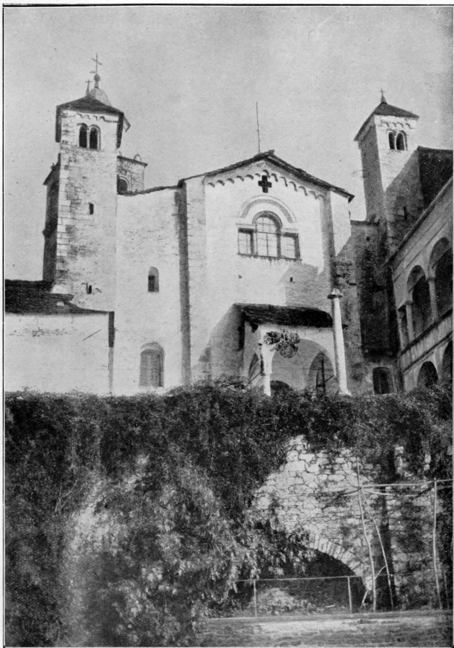
Fig. 11 - Facciata Chiesa con Sagrato.
