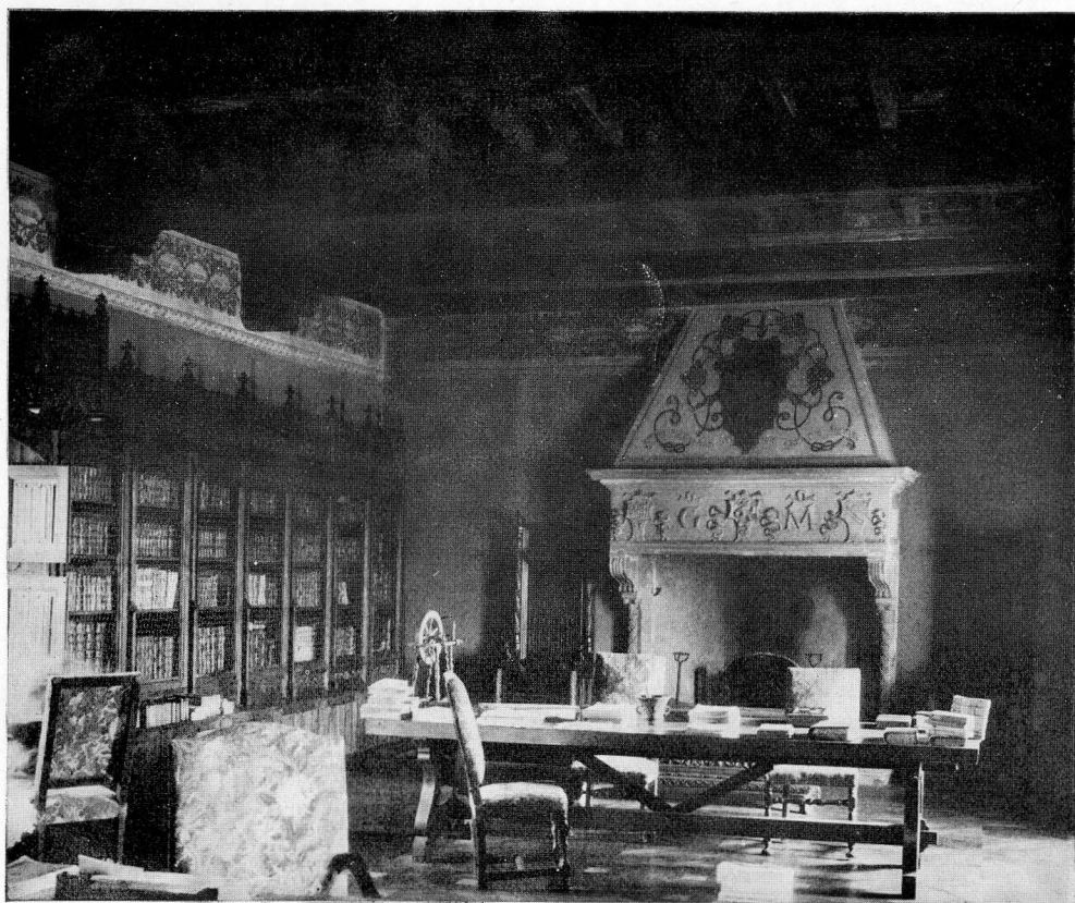
Castello di Malgrà - Nov. 1913 - Biblioteca, scaffali e camino proveniente dal Castello di Fontanetto d'Agogna - Restauro dell'Arch. C. Nigra
