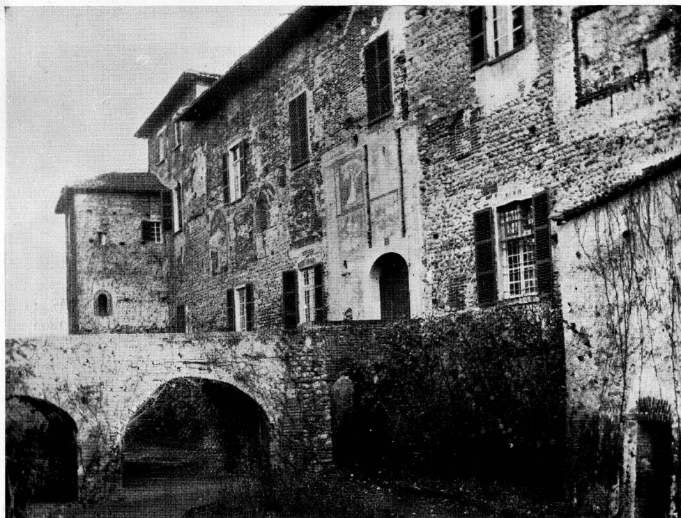
Castello di Malgrà - Prospetto nord prima del restauro (1885)
