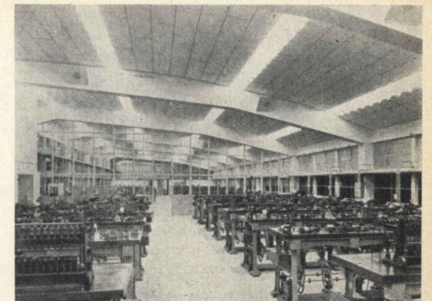
Fig. 2 - Sala lavorazione diamanti. Quattro file continue di tre lampade fluorescenti TL da 40 Watt. - Illuminazione generale 500 Lux. Illuminazione localizzata circa 1000 Lux.
