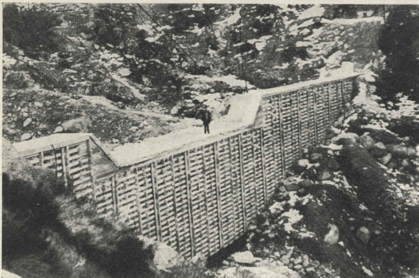
Fig. 4 - Briglia nel T. Ljva (Dora Baltea - Settimo Tavagnasco - Torino). Fa parte di una serie di n. 4 briglie costruite nella gola del monte superiormente al cono di deiezione, sede di coltivi, abitati e linea ferroviaria Ivrea-Aosta, allo scopo di interrompere la discesa di abbondante congerie solida galleggiante su lava fangosa.
