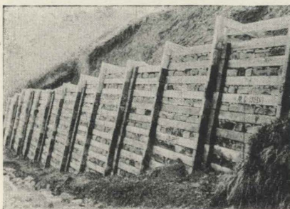
Fig. 9 - Muro di sottoscarpa lungo la strada statale Torino-Savona presso Castino (Cortemilia).
