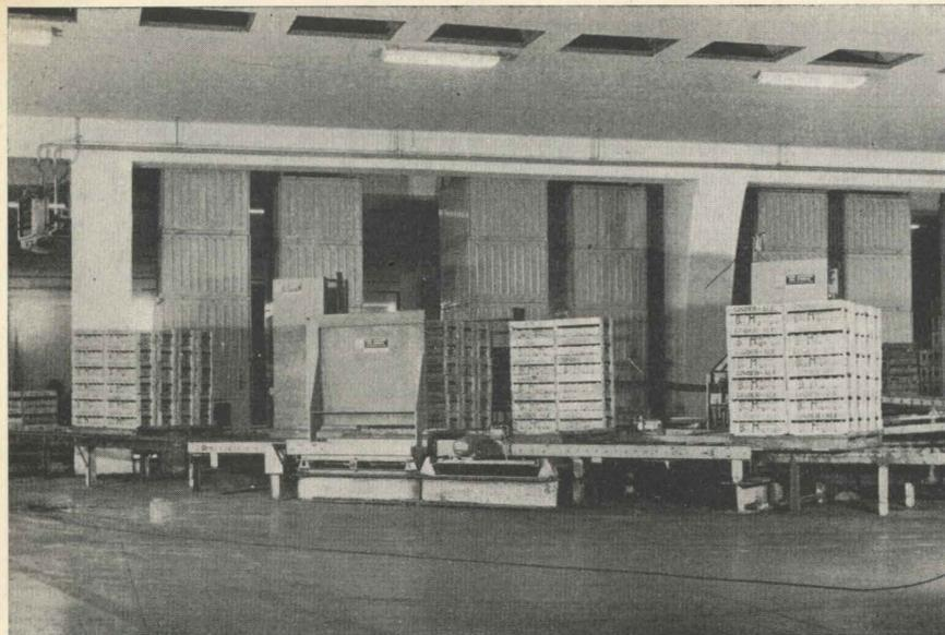
Fig. 5 - Macchine a palettizzare e depalettizzare in funzione presso la Martinas in Belgio.
