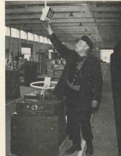
Fig. 6 - Le ferrovie britanniche stanno sperimentando un carrello senza guidatore, noto con il nome di « Robotug ». Il sistema di guida elettronico, prodotto dalla E.M.I. Electronics Ltd., funziona facendo seguire al carrello un cavo metallico collocato appena al disotto del pavimento. La foto mostra un addetto mentre preme il pulsante per inviare un « Robotug » verso un punto distante di un complesso per lo smistamento di merci.
