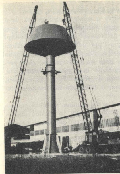
Fig. 4 - Ultima fase di montaggio.
