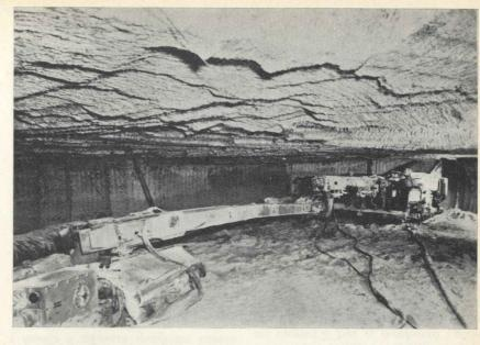
Fig. 4 - Escavatrice integrale, nastro-ponte e nastro trasportatore estensibile (Joy).
