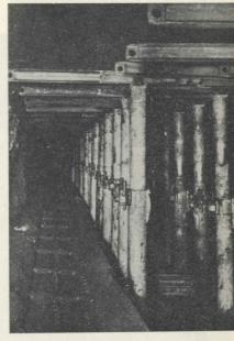
Fig. 2 - Trasportatore ad alette raschianti, impiegato in una lunga fronte di miniera (Bottrop, Renania).
