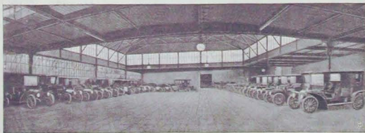
Interno del Garage.
