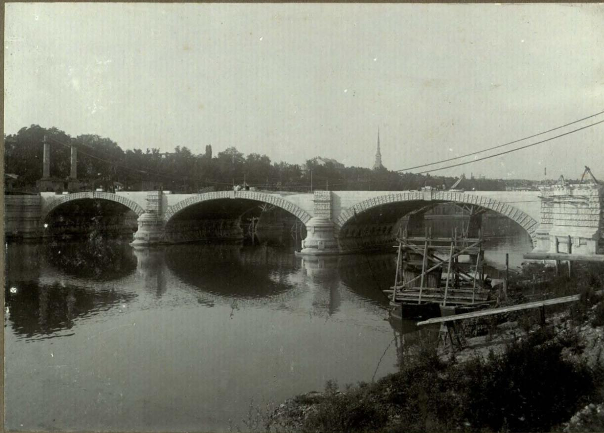
Stato dei lavori nel Giugno del 1906 dopo il disarmo delle arcate
