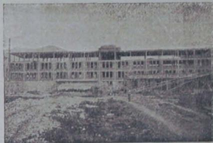
Società Anonima San Giorgio — *Ossatura completa in cemento armato dello Stabilimento di Sestri Ponente (4 solai di 1800 mq. cadauno e platea generale di fondazione eseguiti completamente in 70 giorni).*
