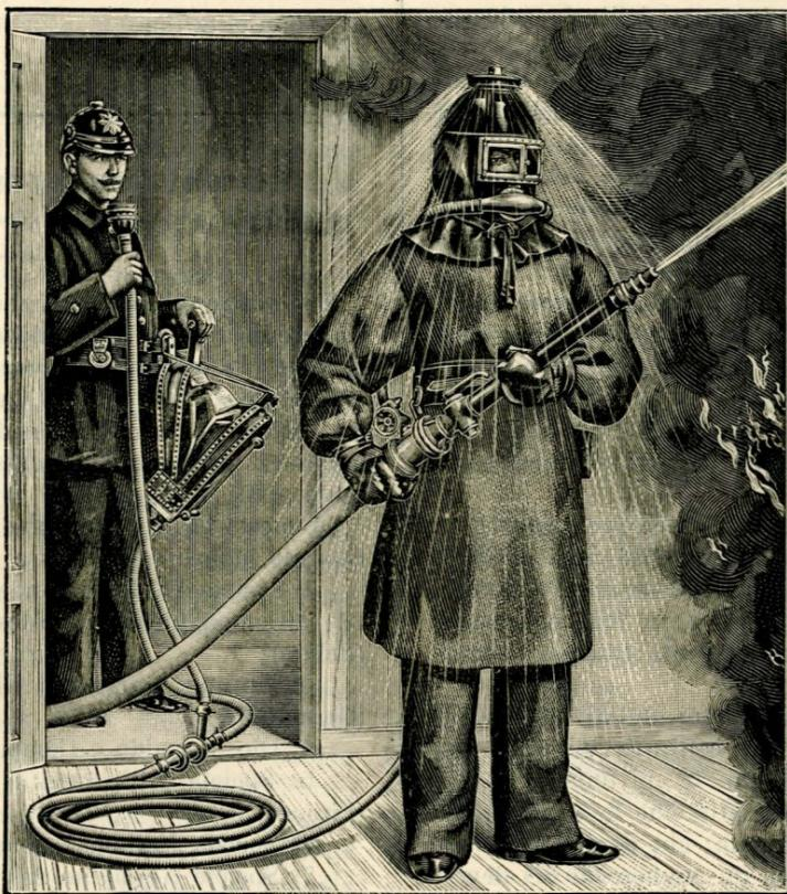
FIG. A. — Apparecchio König per la protezione contro il fuoco ed il fumo.
