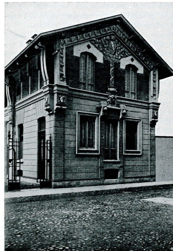
Fig. 6. — Facciata del Lavatoio verso Via Legnano.
