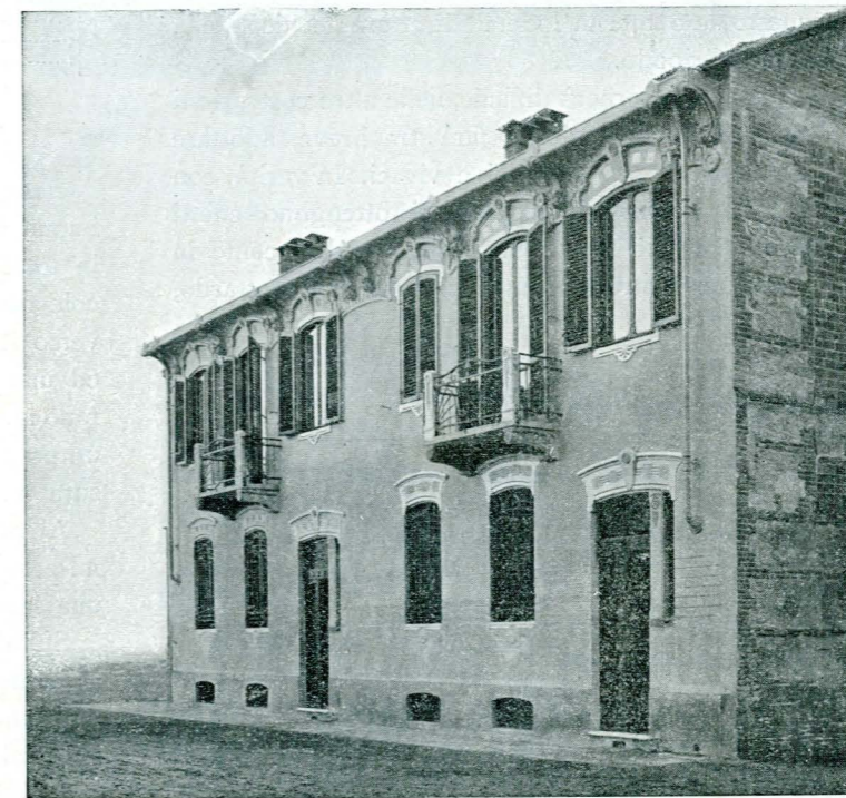
Fig. 1. — Facciata verso strada.
