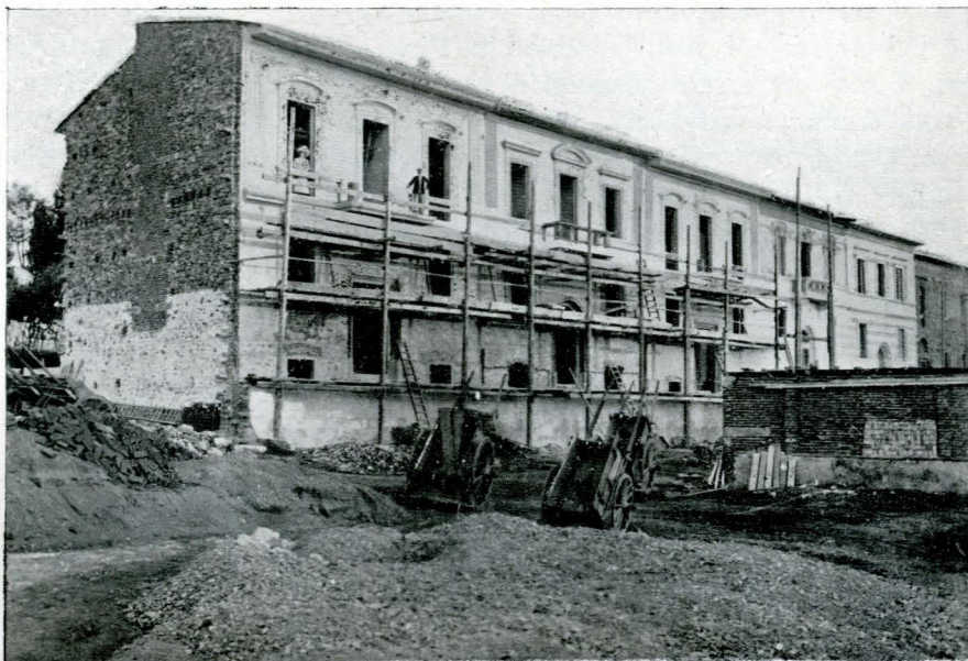
Nuova Etruria - Veduta fotografica delle palazzine in costruzione.
