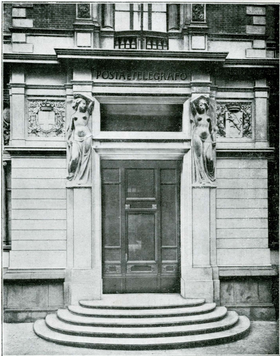
Particolare dell'ingresso principale (via Alfieri).
