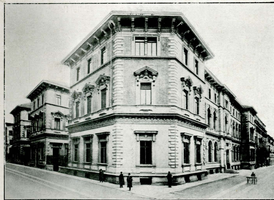
Veduta generale dell'edificio (angolo vie Arsenale e Alfieri).
