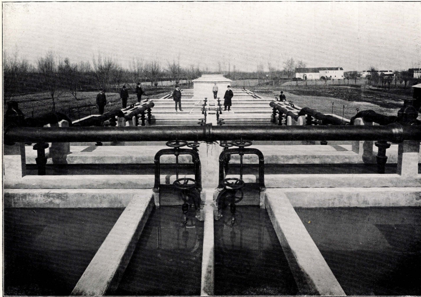
Fig. 11. - Adria. Altra veduta dell'impianto filtrante.
