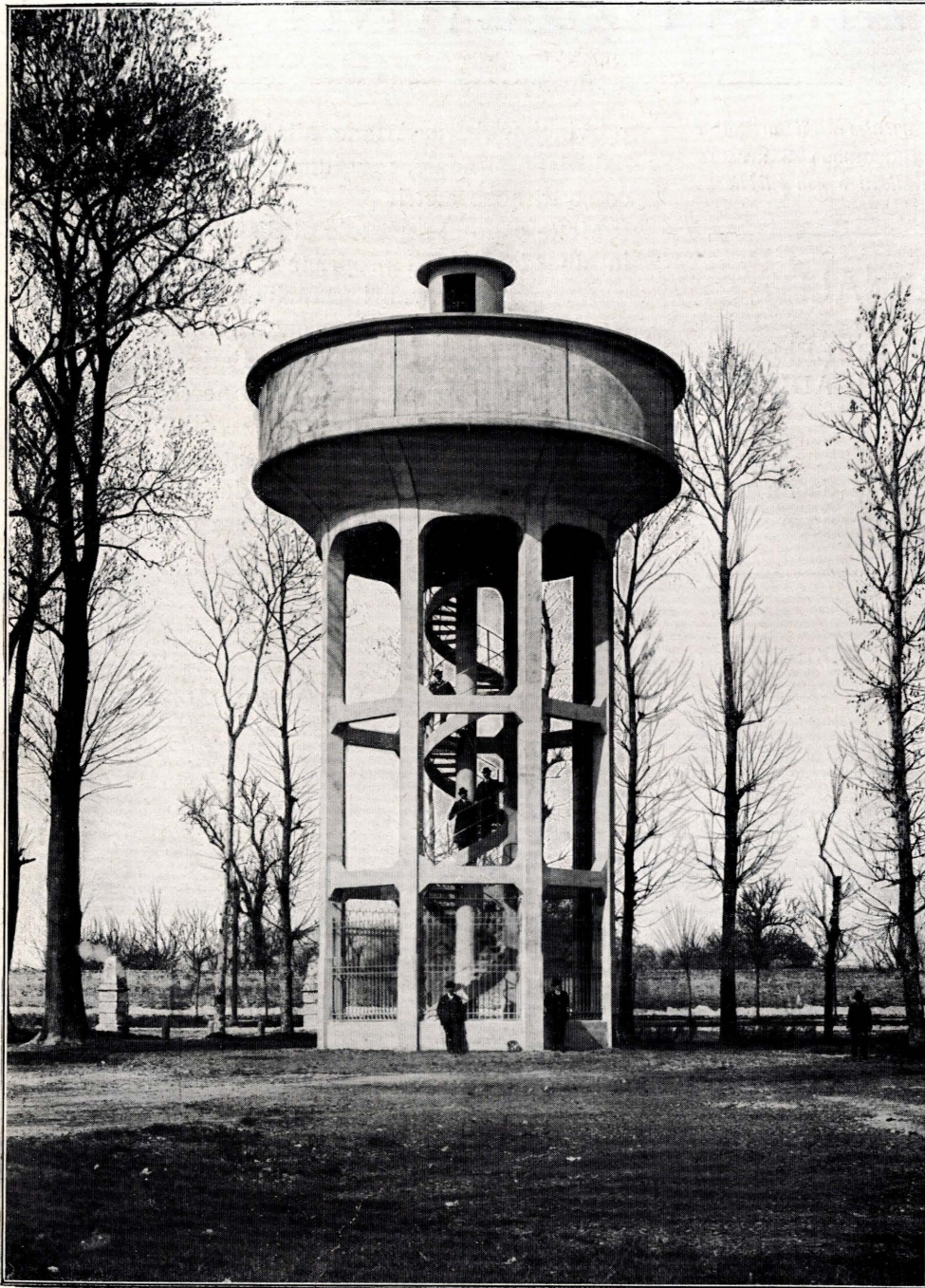
Fig. 9. - Serbatoio di distribuzione.
