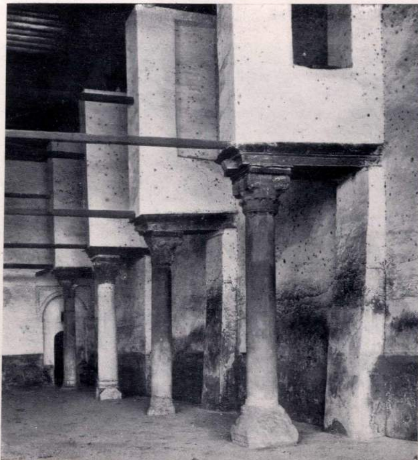
Fig. 14 — Fostât (Cairo vecchio). Moschea di Amr. Una nave estrema con architravi in legno scolpito.
