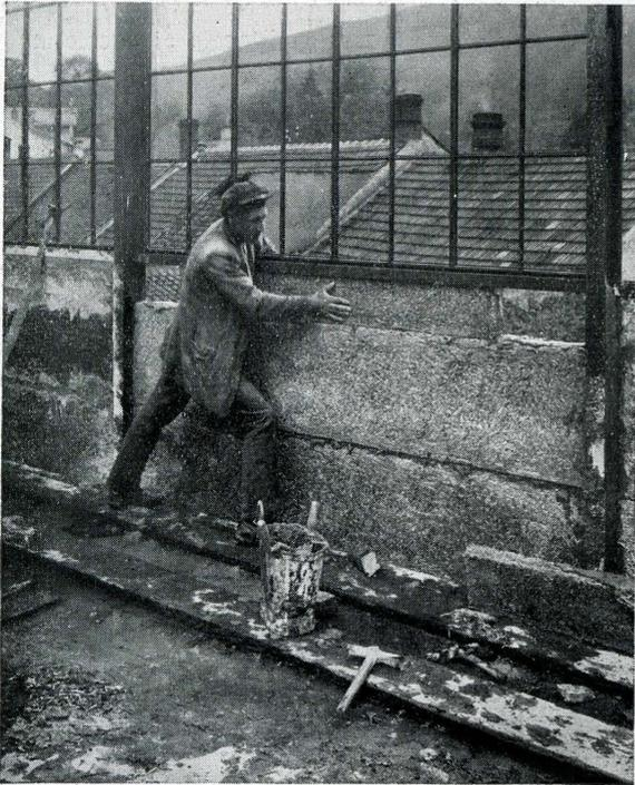
111 - Applicazione dell'Eraclit in una costruzione con ossatura in ferro.
