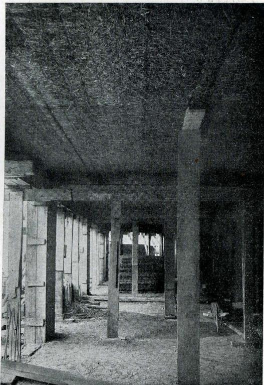
119 - Sottoarmatura in "Solomit" per costruzione in cemento armato, come isolante termico e acustico.
