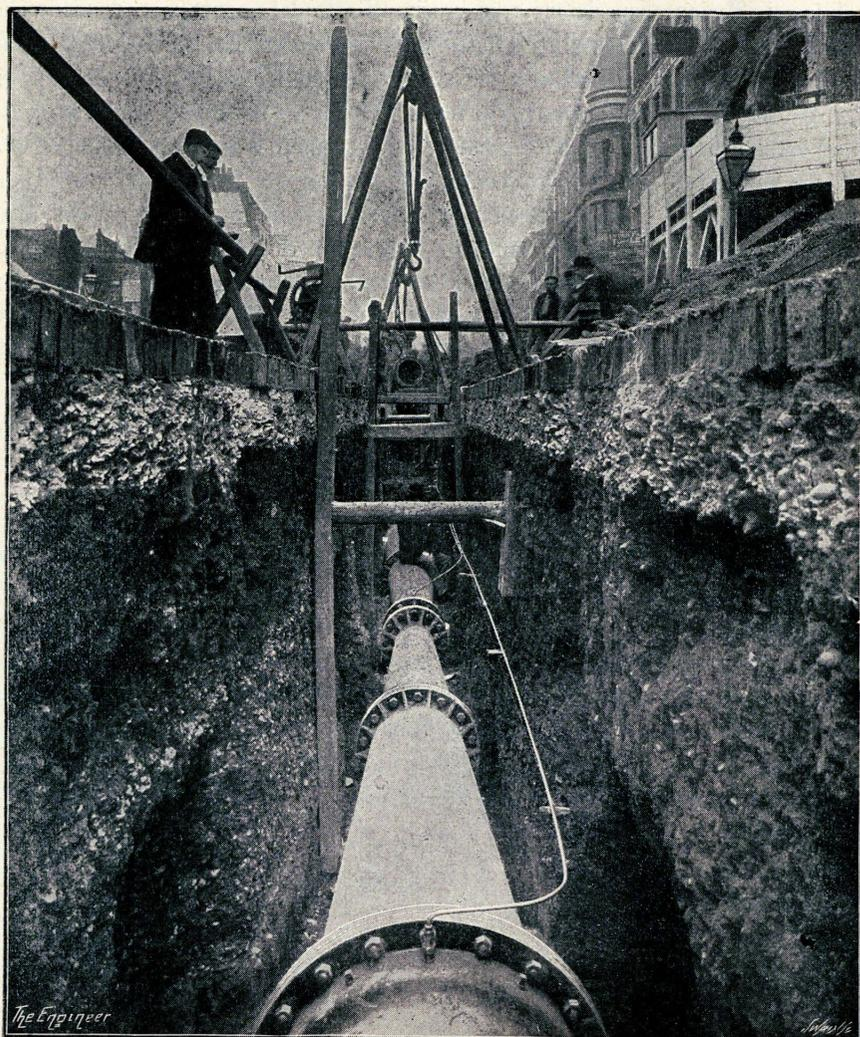
Fig. 118. — Contatore Venturi applicato al servizio dell'acqua potabile di Londra.
