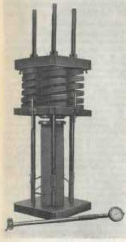
Fig. 1. - Telaio di prova con estensimetri elettrici sulle aste e dispositivo di misura.
