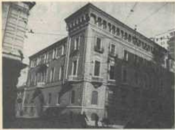
Palazzo Ceriana (1887) - Torino - Via dell'Arsenale ang. Corso Matteotti.
