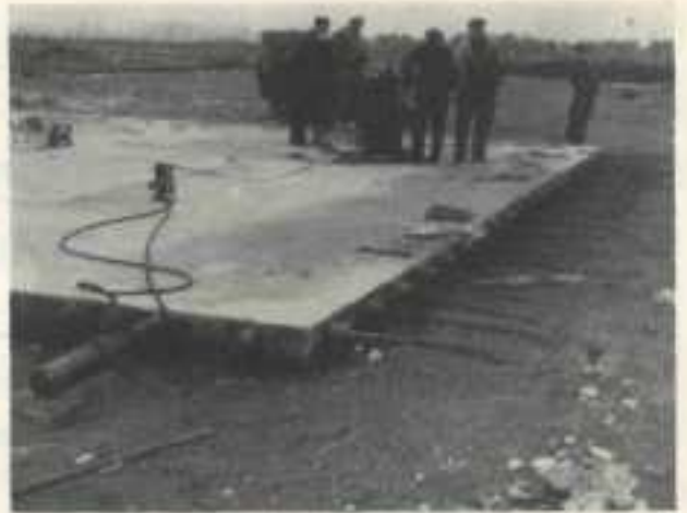
Fig. 5 - Messa in tensione di un cavo.
