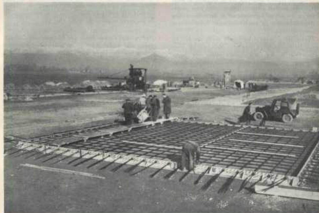
Fig. 3 - Vista d'insieme della lastra durante il getto.
