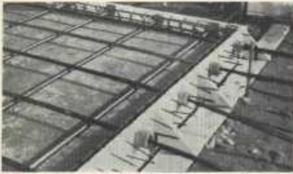
Fig. 4 - Dettaglio dei cavi di precompressione e degli ancoraggi.
