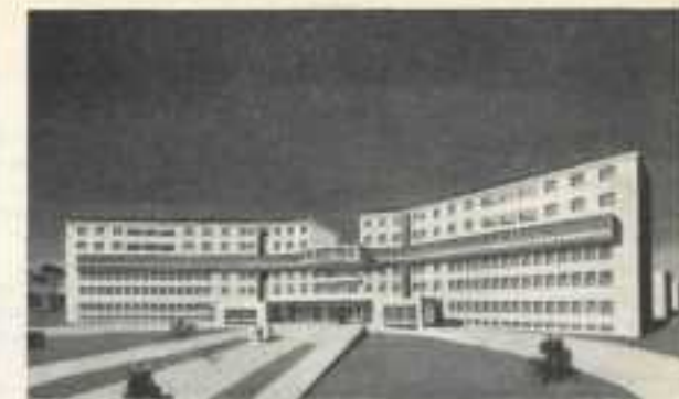
Arch. Ettore Rossi - Veduta da Nord.
