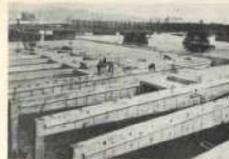
Fig. 9. - Mise en place des dalles de couverture parking couvert à Rouen
