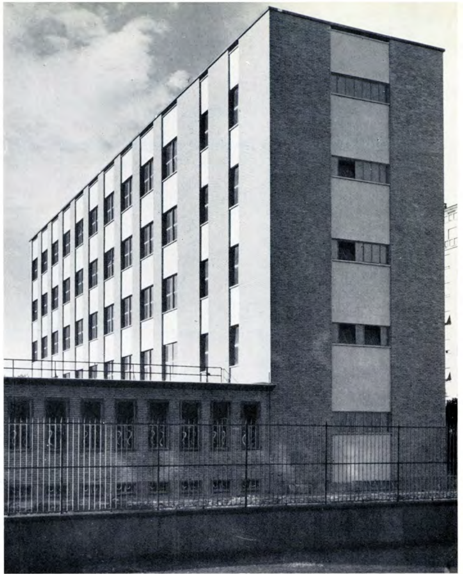
Istituto di Elettrotecnica - Prospettiva del fronte EST.
