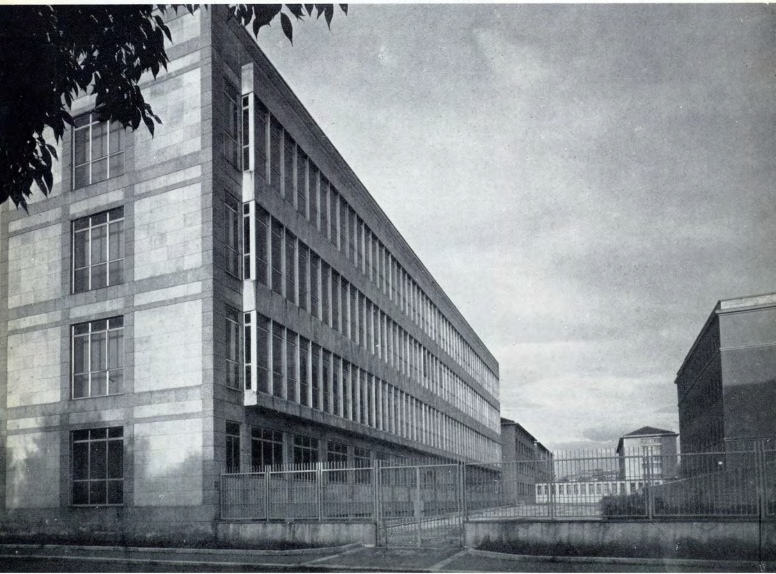
Aule disegno - Vista esterna fabbricato Aule biennio.
