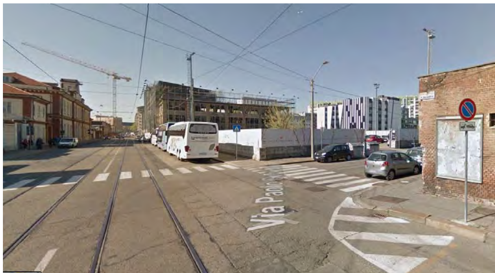
VISTA DA INCROCIO VIA BORSELLINO/VIA BIXIO (VERSO SUD)
