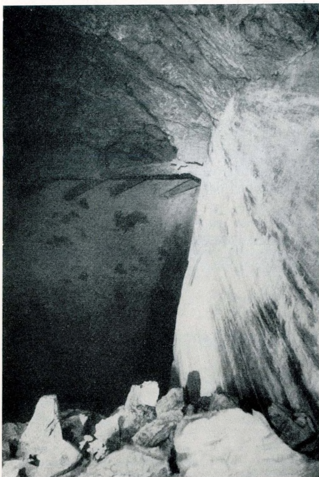
Fig. 10 - Specchio di faglia scoperto dal rilassamento della nuova camera pompe, come appare dal cunicolo di accesso (sul fondo sono visibili la parete Nord della camera e dettagli delle armature).
