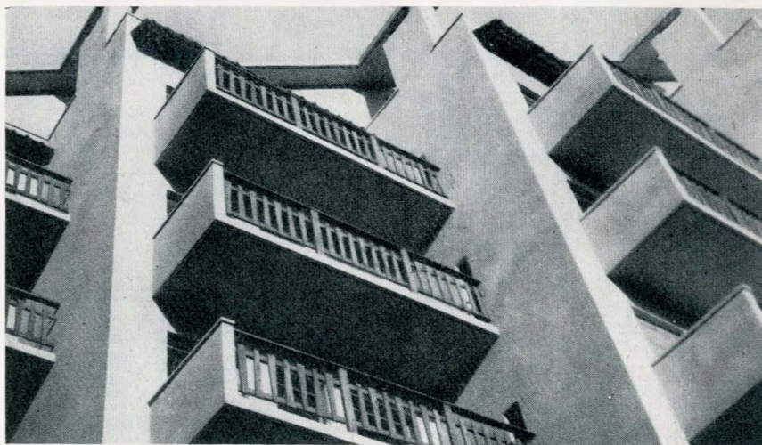
Fig. 6 - Balconi orientati nel Palazzo Solarium a Bardonecchia (arch. E. Pellegrini).
