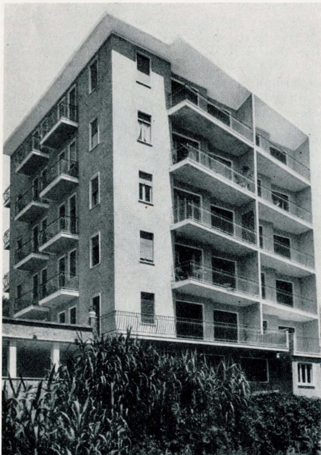
Fig. 1 - Villa Arcadia a Rapallo, primo lotto. Si notino le stanze prospicienti i grandi balconi orientate verso il mare.
