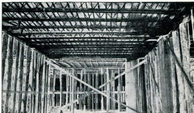
2) L'Impresa F.lli ROMANONI ha iniziato la costruzione impiegando il normale armamento in legname. Dopo il getto di una soletta, l'Impresa ha voluto provare il nuovo sistema di armamento con travi metalliche HICO. I risultati furono eloquenti. Mentre con l'impiego di armature in legname, l'avanzamento dei lavori corrispondeva ad un getto di soletta ogni 8 giorni, l'impiego delle travi HICO consentiva il getto di una soletta ogni 4 giorni, senza aumento di mano d'opera.
