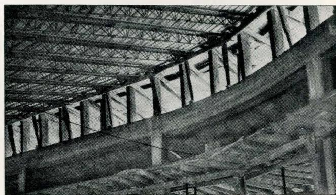
4) Contemporaneamente, l'Impresa F.lli ROMANONI, impiegava le travi HICO con ottimi risultati nella costruzione di un solaio, in un'ala dell'Ospedale Fatebenefratelli in Milano. La copertura era a falde inclinate, su di un'edificio d'angolo, ed aveva una luce di m. 7,40 ad un'altezza di m. 4,50 all'imposta più bassa. Ancora una volta le travi HICO permisero di realizzare forti economie di legname e maggior rapidità di avanzamento dei lavori.
