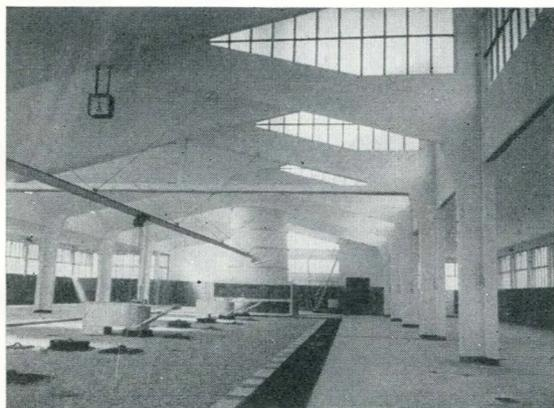
Copertura a shed a quadruplica esposizione ottenuta con volte sottili di paraboloidi iperbolici.
