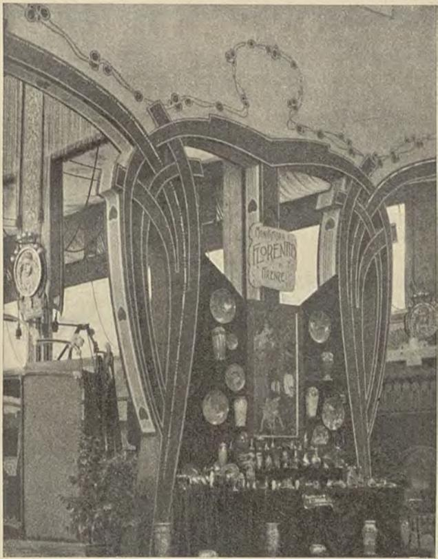
Fig. 112. Sostegni in legno della Galleria principale.
