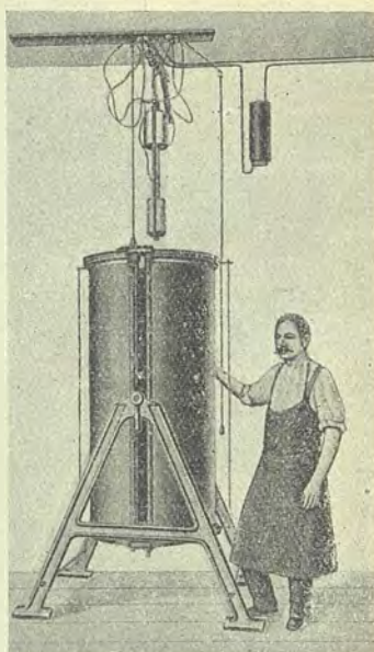
Fig. 652. — Apparecchio « Rapid » per riprodurre disegni con la luce elettrica.
