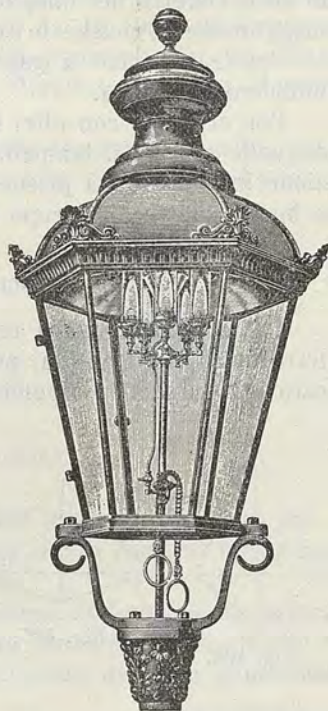
Fig. 404. — Lantern stradale con gruppo di fiamme e con riflettore.
