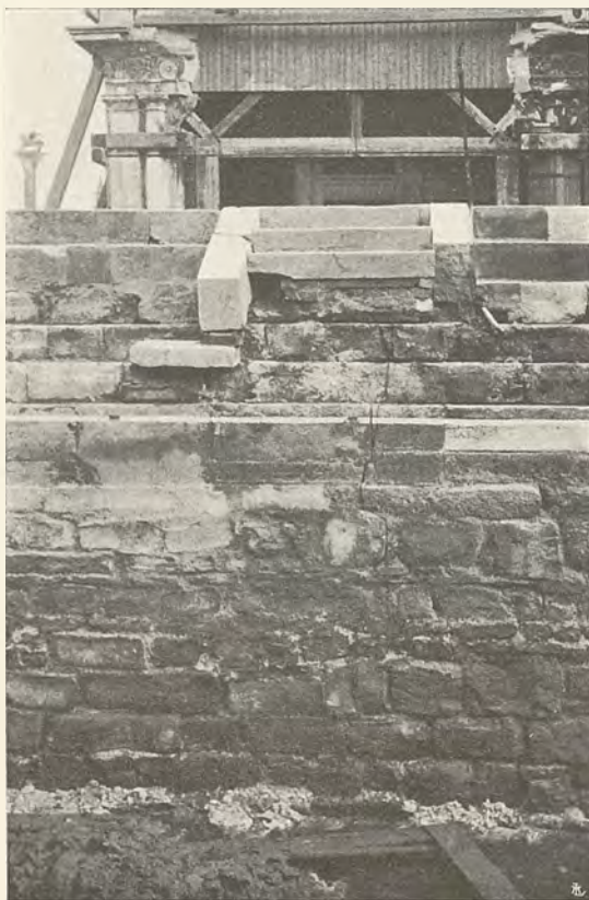
La Scala d'accesso al Campanile, e la sottostante lesione — marzo 1903.
