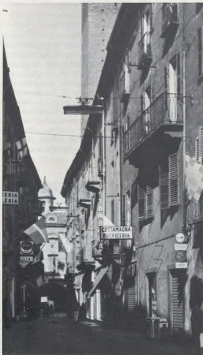
Fig. 61 - Scorcio dell'ambiente della Via Maestra ristrutturato nell'800 con disegno unitario. La continuità di fronti e cornicioni, concorre con il ritmo serrato delle aperture e la sobria decorazione delle modanature a caratterizzare felicemente un lembo di tessuto urbano.
