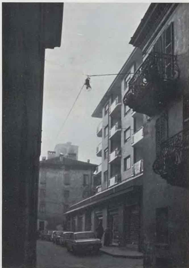
Fig. 69 - Scorcio di un nuovo condominio prossimo alla piazzetta di S. Giuseppe: (196) analogamente a quanto illustrato in fig. 67 si sono operati arretramenti stradali multipli per guadagnare volumetria preziosa, in contrasto con quella più modesta e articolata delle antiche costruzioni (cfr. fig. 57, n. 1).
