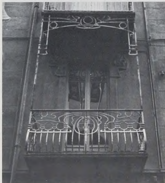
Fig. 43 - I « ferri » della casa Varaldi, già illustrati in dettaglio in fig. 41; vengono ora ripresentati in una visione di insieme della decorazione metallica che, collegando più balconi, diviene partito compositivo fondamentale nel disegno della facciata.
