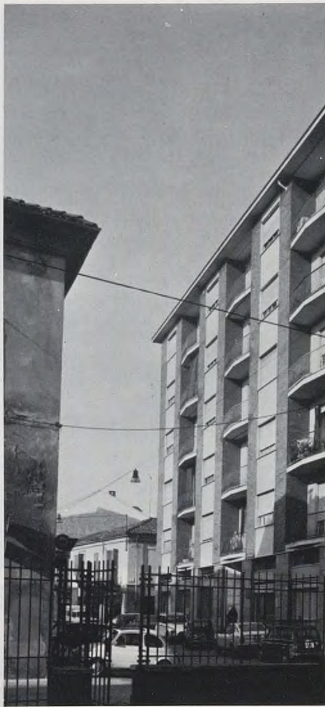
Fig. 77 - Condominio di recente costruzione a fianco della Chiesa di S. Domenico. La vicinanza con la bella costruzione medioevale non ha suggerito particolari attenzioni nella concezione architettonica del nuovo edificio.
