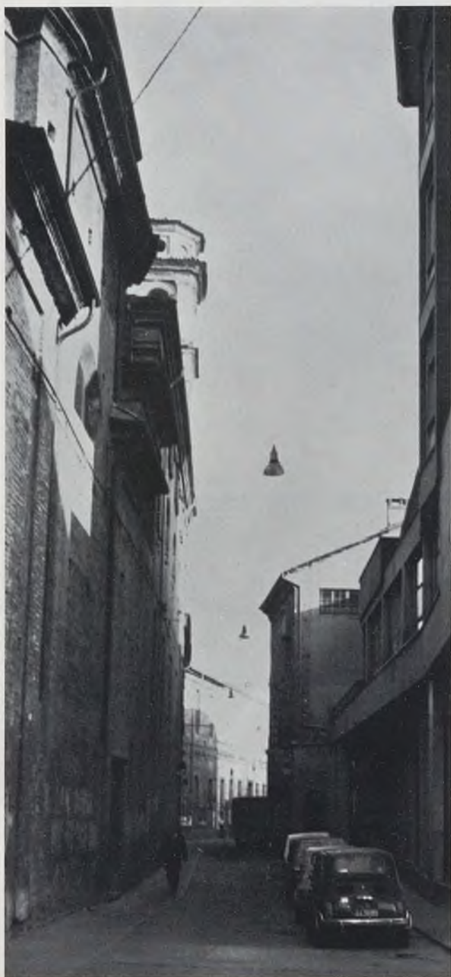
Fig. 76 - Scorcio di Via Parruzza con il fianco della Chiesa della Maddalena. Il risvolto del nuovo edificio non risolve l'attacco con le antiche costruzioni rimasto slegato pur dopo la formazione del breve portico a piano stradale.
