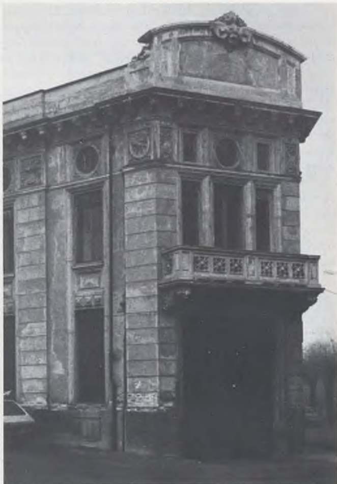
Fig. 44 - L'edificio posto all'ingresso della città dal ponte sulla Cherasca è nato come parte di un complesso industriale ed ora adibito ad uffici. Interessante lo schema compositivo a ritmatura delle strutture verticali evidenti, intercalate con i lunghi tagli delle finestre incolonnate. Molto interessante il coronamento nel quale compaiono alternate aperture di piccole dimensioni quadrate e tonde sovrastate da uno pseudo parapetto a nascondere la copertura. Edificio di indubbio interesse per i richiami a Behrens e ad esempi viennesi di inizio secolo.
