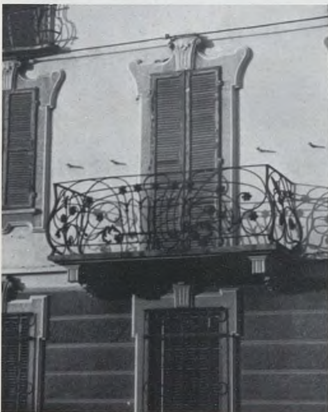
Fig. 35 - Soluzione decorativa in ferro di un edificio a S. Damiano d'Asti che con un ritardo di almeno venti anni riecheggia scelte compositive proprie dell'inizio del secolo.
