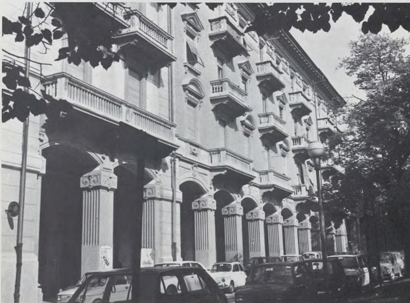
Fig. 31 - I palazzoni della Via Roma costituiscono un intervento di notevole importanza per la città, che si realizza tra il 1916 ed il 1930. I modi compositivi, pur diversi da quelli tradizionalmente adottati, si amalgamano bene con la preesistente edilizia albese.
