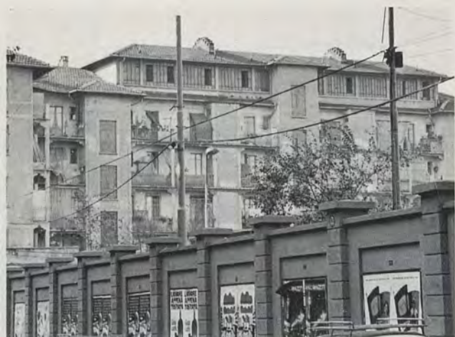
Fig. 3 - Particolare, vetrate locali ex stenditoi nei sottotetti - Vista su cortile.
