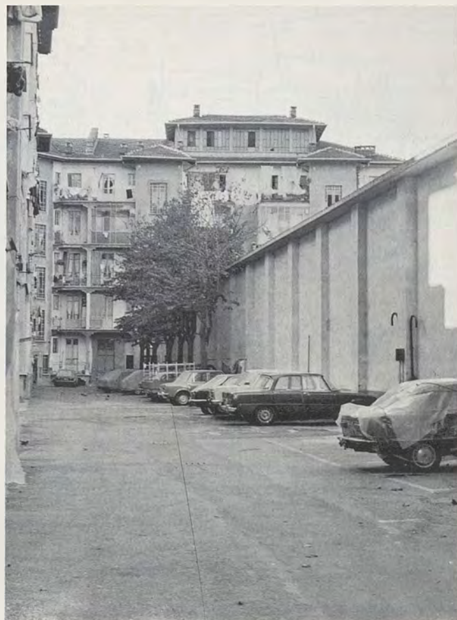
Fig. 5 - Vista del cortile, si noti la limitata disponibilità dell'area vincolata dai depositi ATM incombenti sul Quartiere.
