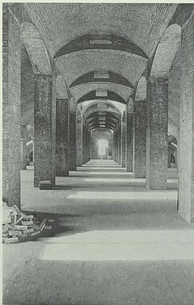
Fig. 29 - Sottotetto del pad. IX. Gli archi trasversali rinfianchati sono stati aggiunti in un secondo tempo per correggere la non felice configurazione della volta a botte centrale.
