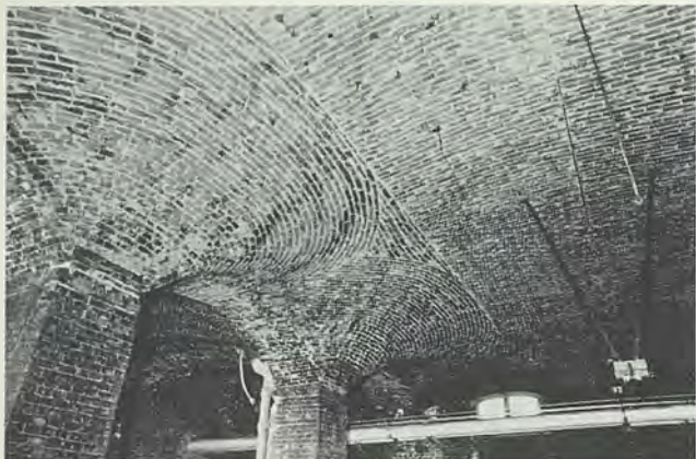
Fig. 35 - Apparecchio scoperto d'una volta a fungo nel sotterraneo del pad. VII. Sulla sinistra s'intravede l'apparecchio simile, ma concavo, d'una vela.
