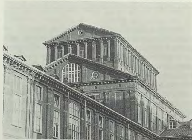
Fig. 44 - Pad. V. Il blocco emergente del matroneo, e, sul tetto di quello, il tiburio che avvolge la cupola.
