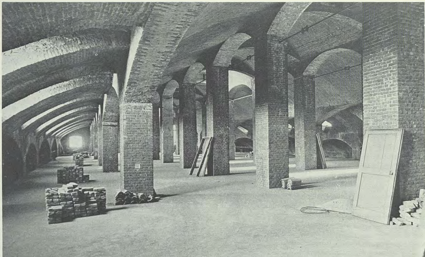
Fig. 30 - Sottotetto del pad. IX. Si notino i sistemi longitudinali di chiavi apparenti. Fig. 31 - Sottotetto del pad. IX. Intradosso di un abbaino che illumina il corridoio centrale. Si osservino l'inspessimento del bordo delle botti, la volta cilindrica di quarto dell'abbaino e i tiranti che impediscono il divaricamento delle travi ad I che l'impostano. Fig. 32 - Sottotetto del pad. IX. Campata estrema non utilizzabile. Sono visibili in primo piano l'estradosso di mezza volta a fungo con gli archi di testa ai quali essa si immorsa, e le concatenazioni metalliche trasversali e diagonali.
