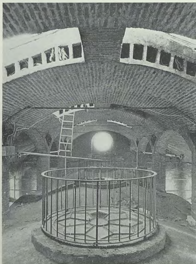
Fig. 54 - Pad. V. Estradosso del volto. Finestre circolari orizzontali praticate nelle volte che chiudono la troncatura del volto, con le ringhiere di protezione. Si notino i lucernari della volta cilindrica centrale, e le gambette che attuano lo spianamento delle falde del tetto.
