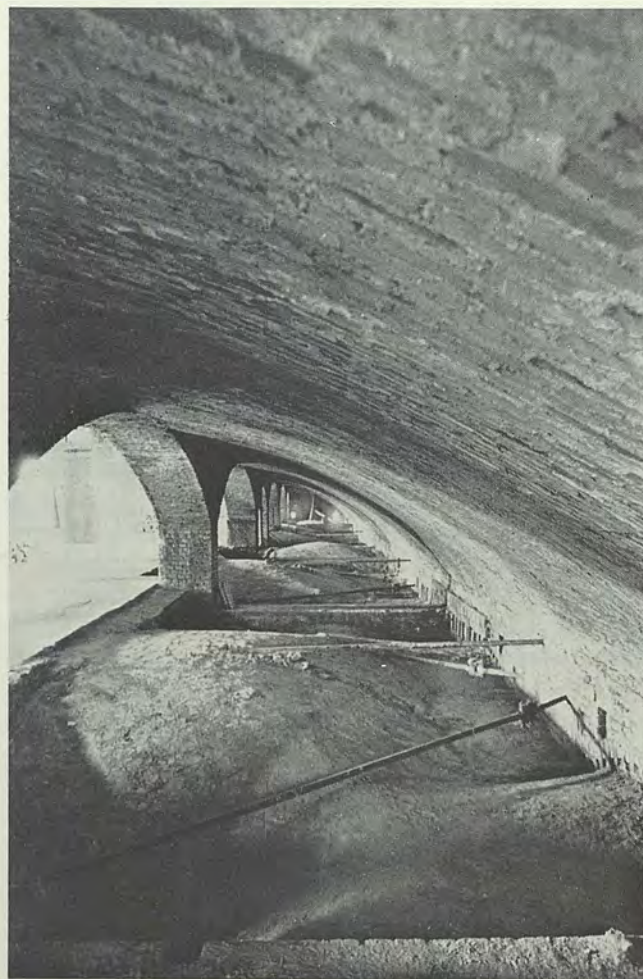
Fig. 30 - Sottotetto del pad. IX. Si notino i sistemi longitudinali di chiavi apparenti. Fig. 31 - Sottotetto del pad. IX. Intradosso di un abbaino che illumina il corridoio centrale. Si osservino l'inspessimento del bordo delle botti, la volta cilindrica di quarto dell'abbaino e i tiranti che impediscono il divaricamento delle travi ad I che l'impostano. Fig. 32 - Sottotetto del pad. IX. Campata estrema non utilizzabile. Sono visibili in primo piano l'estradosso di mezza volta a fungo con gli archi di testa ai quali essa si immorsa, e le concatenazioni metalliche trasversali e diagonali.
