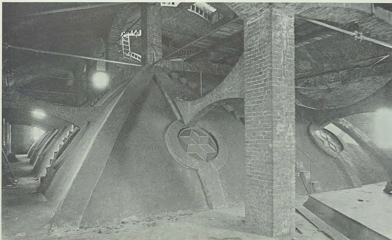
Fig. 51 - Pad. V. Estradosso del volto. Si notino le straordinarie strutture di contraffortamento ad archi diritto-rovesci; le concatenazioni metalliche; le corone circolari dei lucernari che recidono le costole estradosali; i pilastri in falso sul dorso della volta che vanno a reggere la copertura laterizia.
