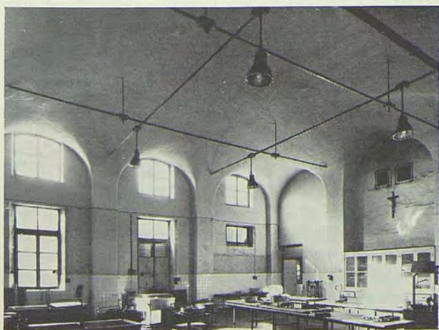
Fig. 58 - Pad. V. Volta della cucina. Si notino i tirantini che appendono le catene longitudinali in corrispondenza delle connessioni. Le catene trasversali poggiano a loro volta sulle longitudinali.
