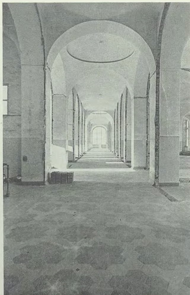
Fig. 26 - Interno del pad. IX (1° piano) durante i lavori di ristrutturazione. Smantellati i diaframmi divisorii, la struttura è ridotta alla sua più pura essenza scheletrica.
