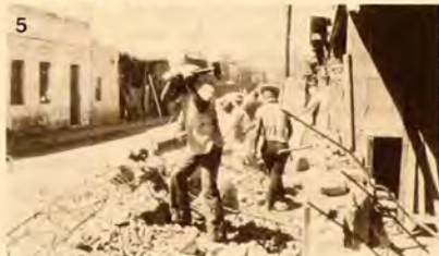
Città del Guatemala 1976: effetti sismici sulle strutture edilizie: 1. Centro Medico: cedimento e smottamento della struttura portante. 2. Edificio di epoca coloniale: crollo della struttura in pietra e argilla. 3. Collegio femminile: danni alle strutture in cemento armato. 4. Distruzione totale di abitazioni povere in laminati metallici e mattoni crudi. 5. Danni gravi a costruzioni in laminati metallici e cemento.
