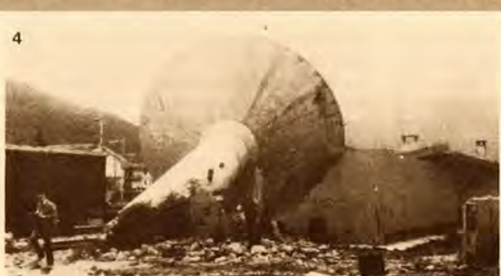
mezzo, 3. Ospedale di Gemona, lesionato nella parte a cinque piani. 4. Serbatoio pensile crollato per rottura della zona inferiore del pilastro, Gemona. 5. Chiesa sulla Statale carnica, Gemona. 6. Edificio gravemente lesionato, Gemona.
