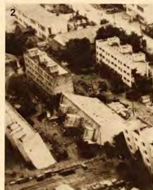
1. Carta delle aree sismiche e vulcaniche dell'Arcipelago nipponico e diagramma dei periodi di ricorrenza dei terremoti. 2,3. Terremoto di Niigata, 1964: crollo di edifici residenziali e incendio degli impianti chimici. 4. Carta sismica dell'area metropolitana di
