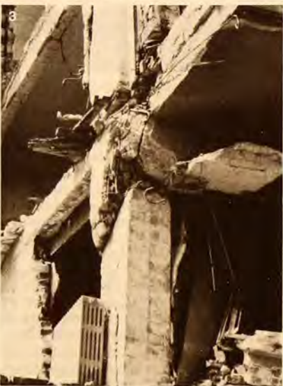
1. Lesioni riportate durante il terremoto del marzo 1977 dal complesso residenziale Wilson costruito tra 1925-1940. 2. Esempio di degrado per friabilità in una facciata. 3. Cedimento totale di pilastri in cemento armato per sollecitazione sismica.
